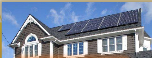
太陽光パネル 4.15kw
