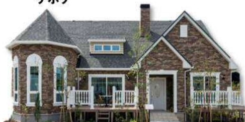
※「エンバカデロ」施工事例
